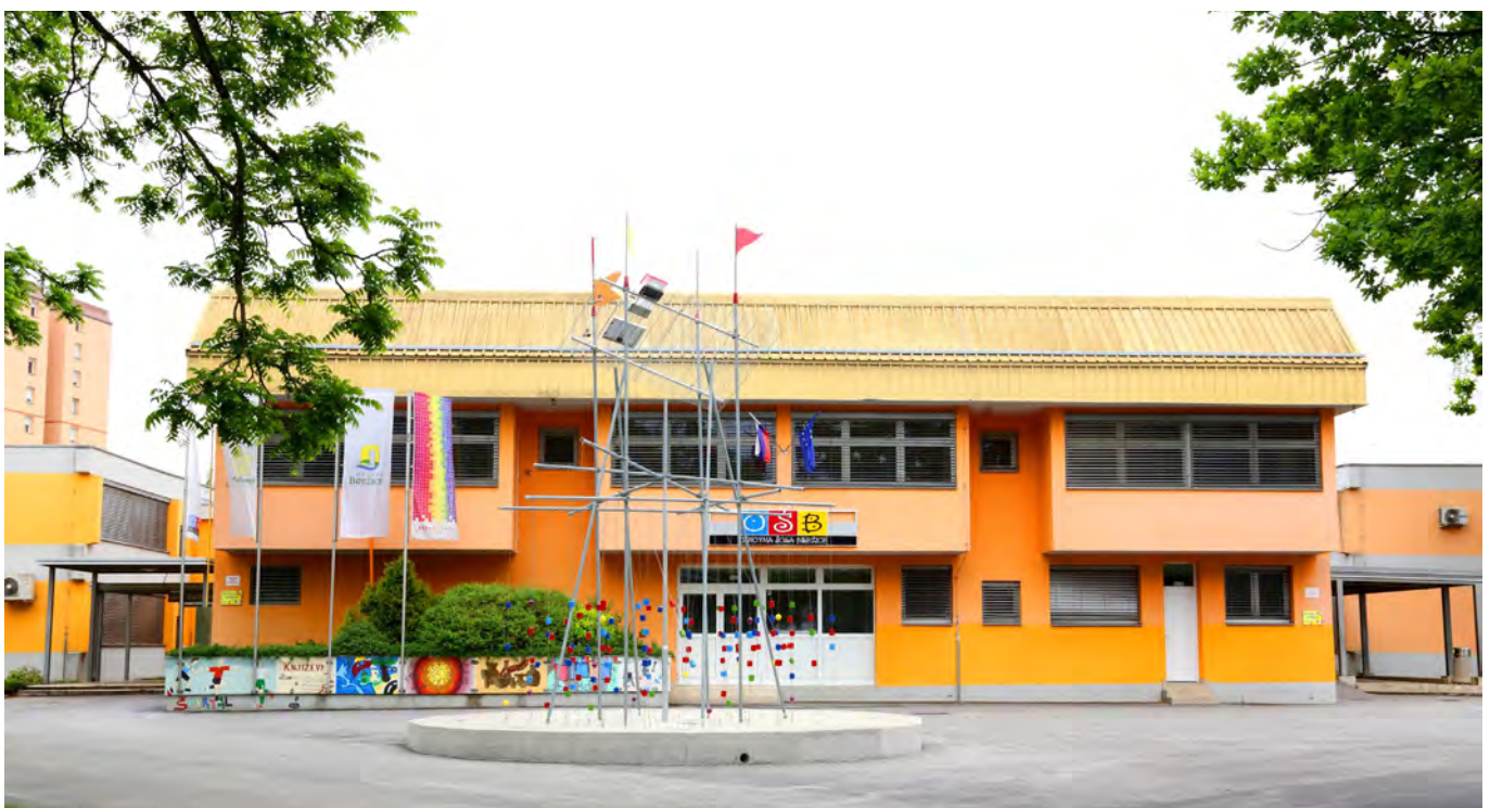
Stavba Osnovne šole Brežice (arhiv OŠ Brežice)
